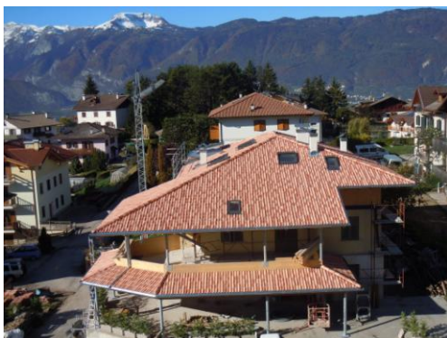
Sopraelevazione in legno di un edificio esistente - Coredo (TN)
