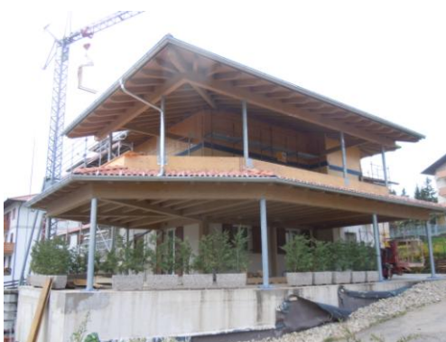
Sopraelevazione in legno di un edificio esistente - Coredo (TN)
